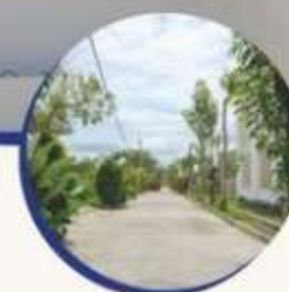
JALAN LINGKUNGAN COR BETON
